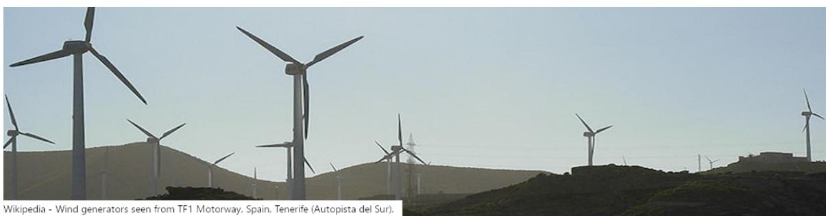
Este tipo de gerador consiste em uma máquina de indução convencional ligada diretamente à rede CA. Opera com velocidade de rotação praticamente constante.
