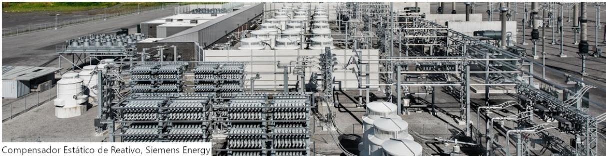
O **Compensador Estático de Reativo (CER)**, em inglês *Static Var Compensator (SVC)*, é um dispositivo de eletrônica de potência constituído pelos seguintes elementos básicos: Reator Controlado a Tiristor (TCR – *Thyristor Controlled Reactor*) associado com um banco de capacitores fixos ou chaveado.
