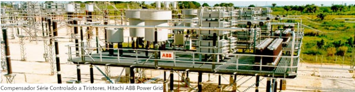
Compensador Série Controlado a Tiristores, Hitachi ABB Power Grid
